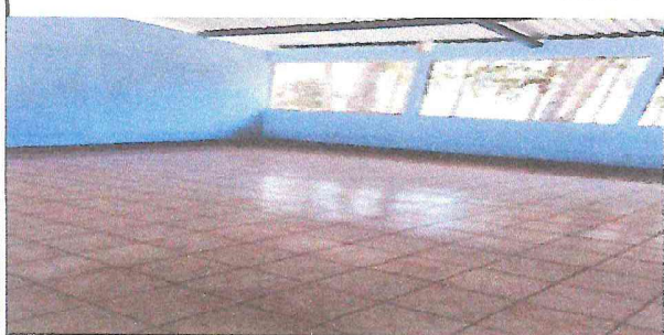
Foto 3: Piso de torta de cemento de la escuela a piso cerámico
