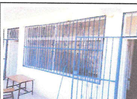
Foto 6: balcones de la escuela
