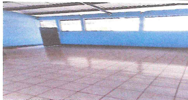
Foto 4: piso de torta de cemento de la escuela a cerámico
